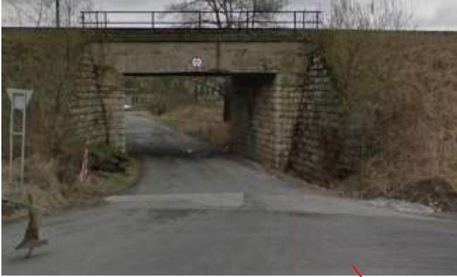
Železničný most, podjazd smerom ku ČOV
